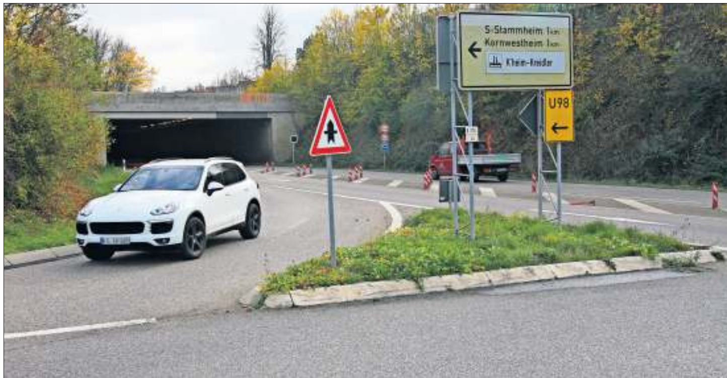
Note mangelhaft: Die Kreuzung vor dem Tunnelmund soll umgebaut werden, jedoch nicht vor dem Jahr 2019.
